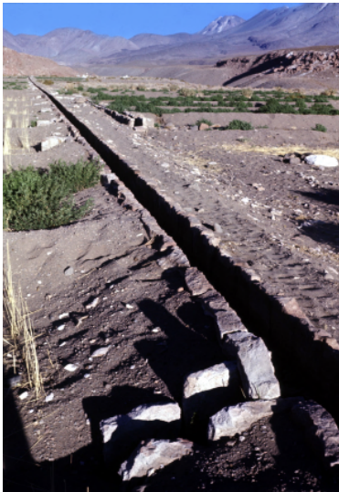
Increíble labor de nivelación
